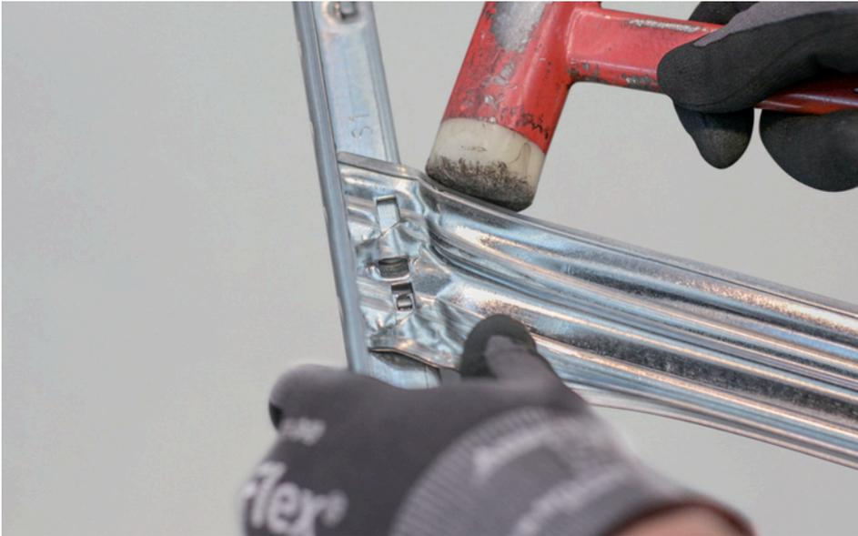
Iniziare l'assemblaggio installando la prima diagonale. Posizionare i fori dell'estremità superiore della diagonale sugli agganci del montante. Con l'ausilio di un martello gommato, procedere al serraggio parziale fino a far indentare i fori della connessione inferiore sugli agganci del montante opposto.
