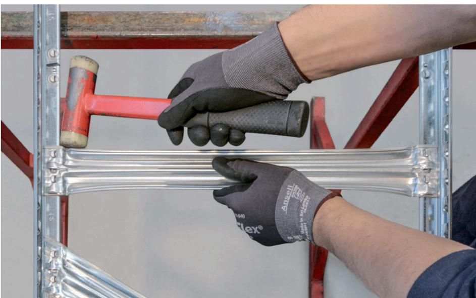
Premendo le connessioni del distanziale orizzontale sui montanti, battere entrambe le estremità fino al serraggio completo e all'attivazione dell'antiscivolo. Se necessario, ruotare leggermente il montante tenendo premuti i fori di connessione contro gli agganci per agevolare la presa. Portare a completo serraggio.
